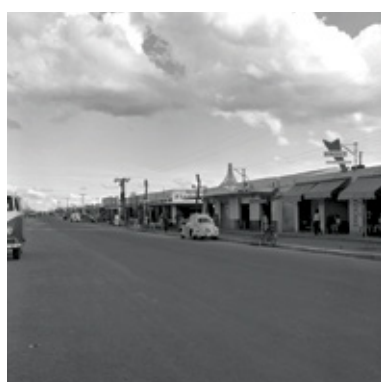
Centro Comercial de Taguatinga • 1964 C | Arquivo Público do Distrito Federal
